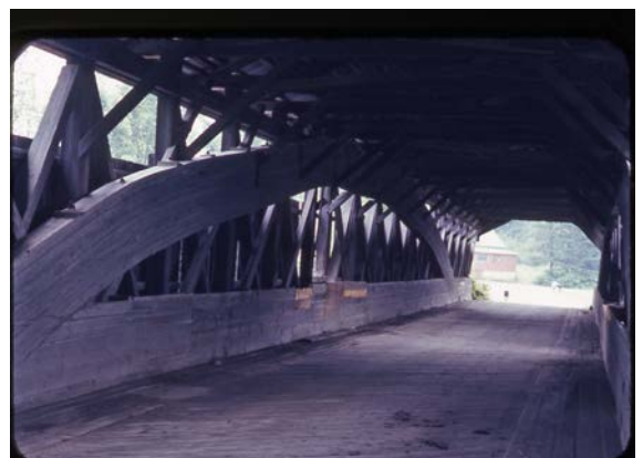
写真 2 Swiftwater Covered Bridge の内部
