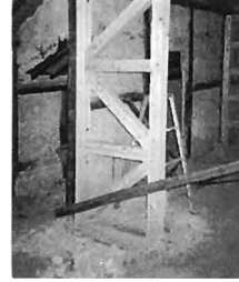
写真5 二階袖壁筋違
